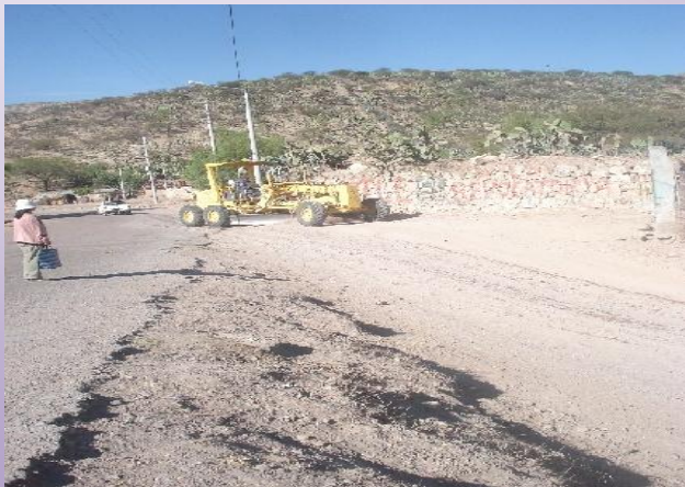
Camino vecinal puente Laramate Shacco mantenimiento y conservación
