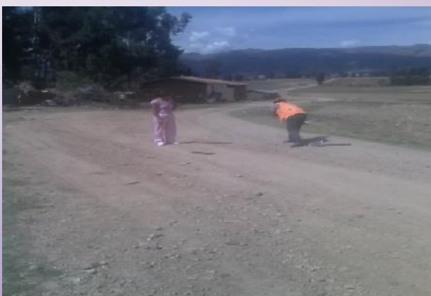
Supervisión del tramo Lampamarca Lampamarca estado actual transitable
