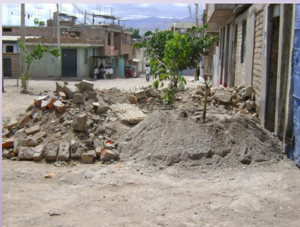
Supervisión de actividad de construcción.
