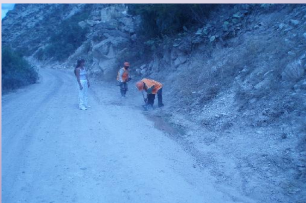
Supervisión de actividad limpieza de cunetas tramo Muyurina Niño Fucas
