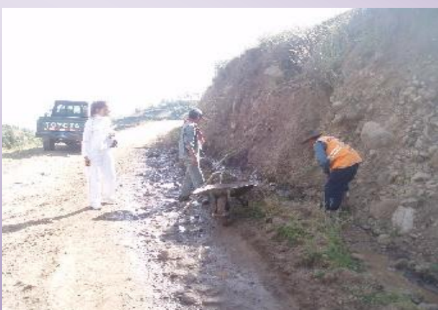
Supervisión del tramo Shupas - Chicara estado actual transitable
