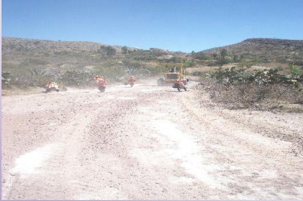
Camino vecinal Shacco Mituccasa mantenimiento y conservación del tramo
