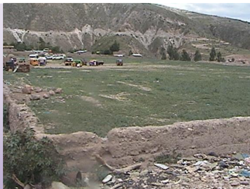
Construcción terminal terrestre interdepartamental
