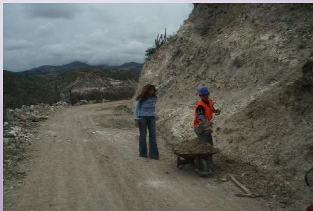
Supervisión de actividad limpieza de cunetas tramo Santa Elena Huatatas
