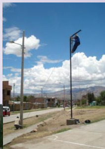
Construcción del acceso al coliseo y el estadio del rehabilitación e iluminación de 09 leas deportivas en la zona metropolitana, provincia de huamanga - ayacucho
